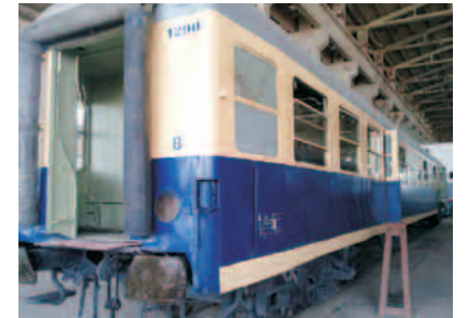
La reparación de los coches para los trenes de Manzanillo y Santa Clara es imprescindible
